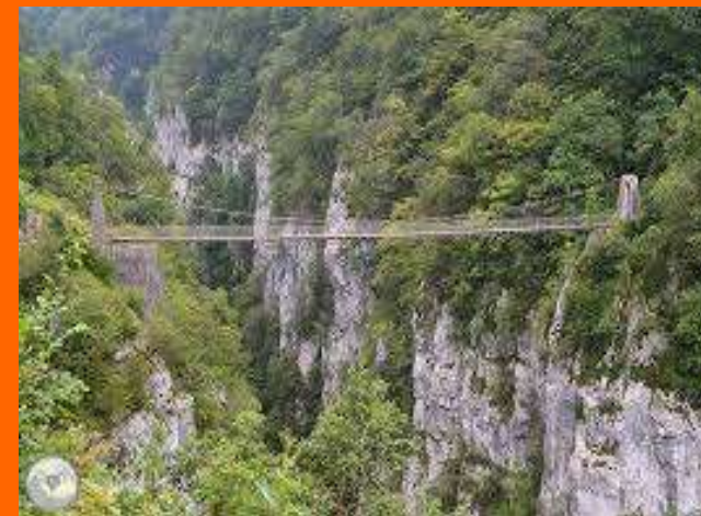
Pasarela de Holtzarte
