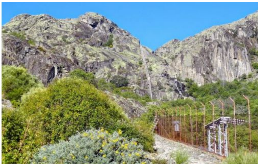
La Central del Chorro y la tubería que baja desde la laguna del Duque
