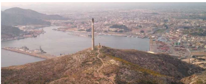
Chimenea de Peñarroya.
